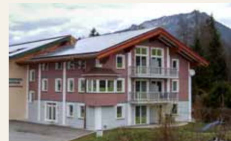
Das Effizienzhaus Plus in Bischofswiesen erzeugt mehr Energie, als es verbraucht. Quelle: Mario Stelzmann
